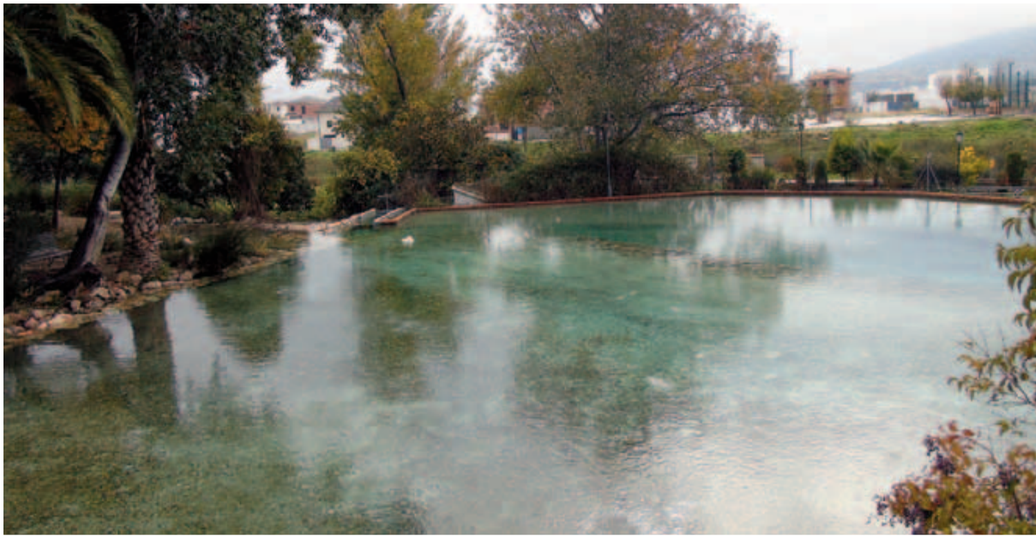
El embalse se construyó hace más de un siglo y posteriormente tuvo que ser mejorado para permitir la captación de agua para la red de abastecimiento. FOTO: J.Mª JIMÉNEZ
