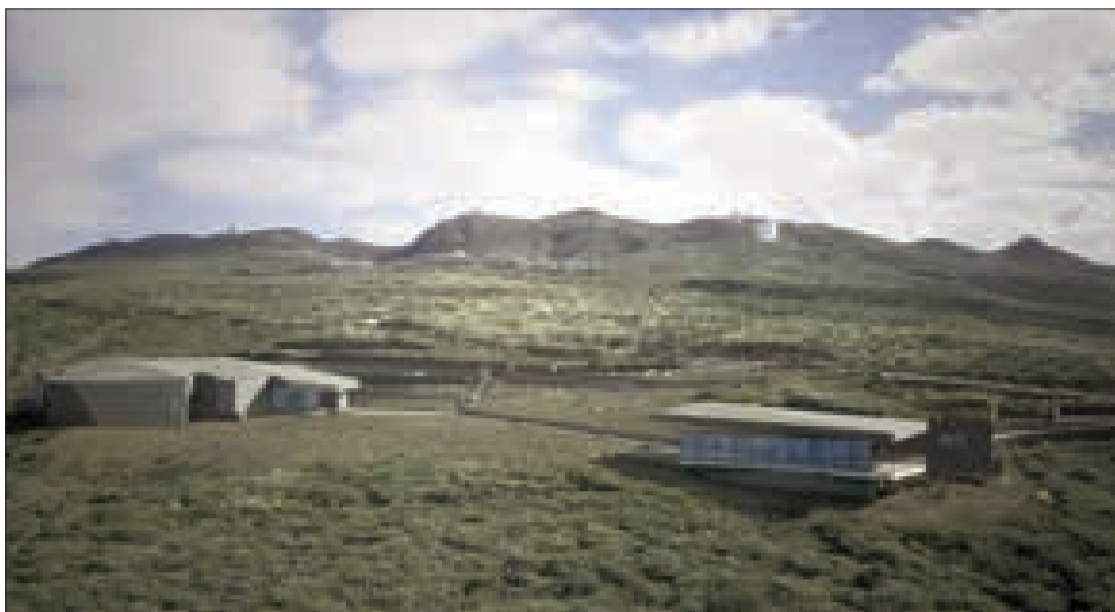
Centro de visitantes en el Observatorio del Roque de los Muchachos.
