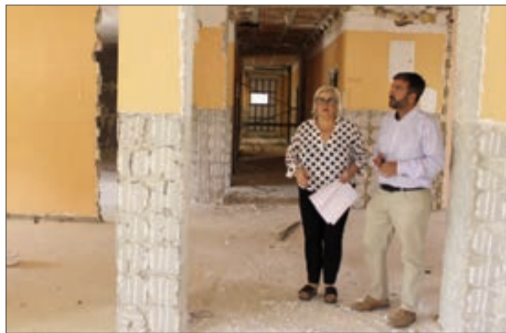
El alcalde y la concejala visitan el desarrollo de las obras. FOTO: C. MOLINA
