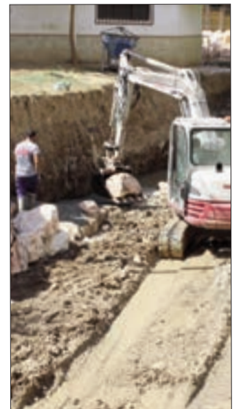
Creación de muro en el Río Frío.
