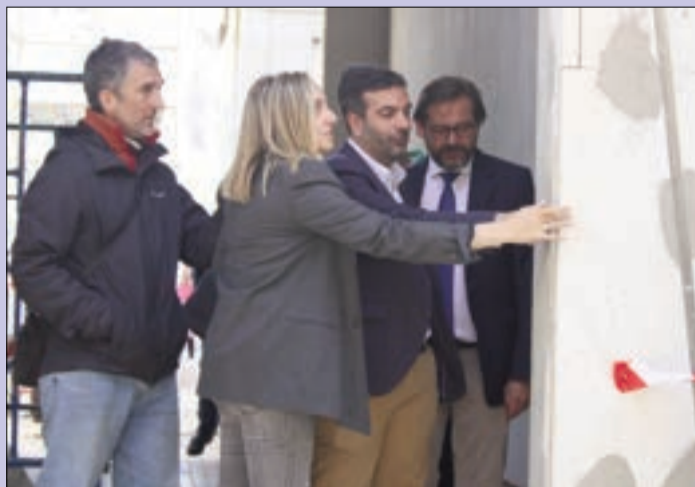
La consejera y el alcalde comprueban el revestimiento de las viviendas. C. M.
