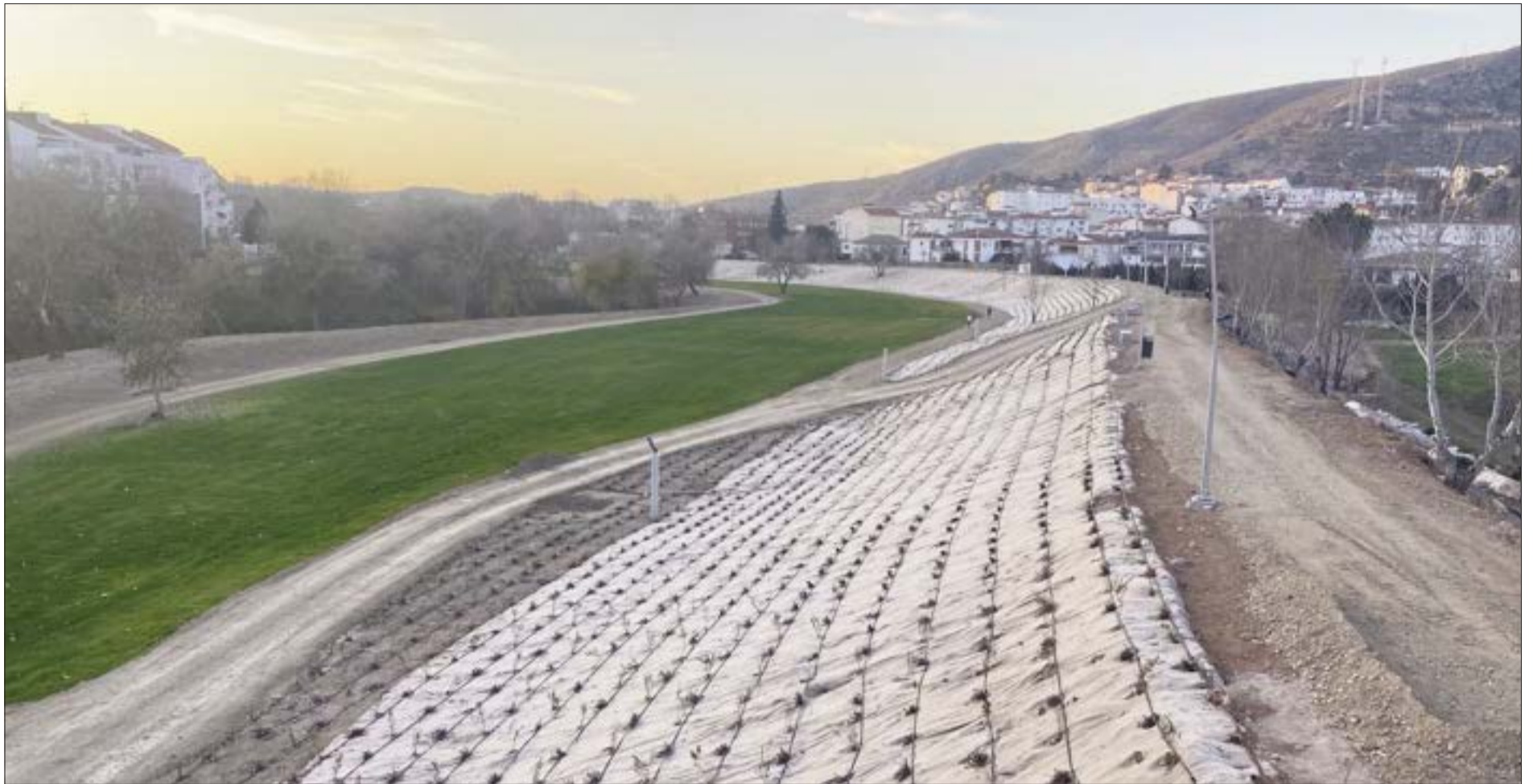
La primera fase del primer parque fluvial de la provincia va cogiendo forma a falta de actuar en la plaza del tercer ojo del puente y en la zona del encauzamiento hasta el Pabellón Alfeia . FOTO: EL CORTO
