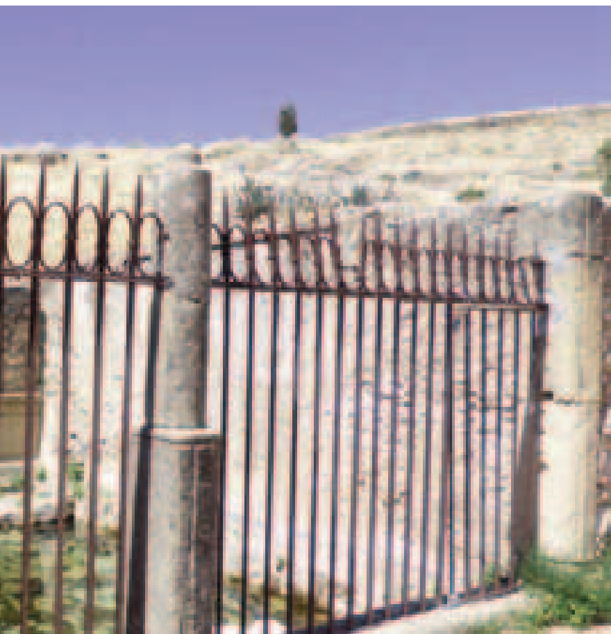
... tres alturas y obra de cantería.
