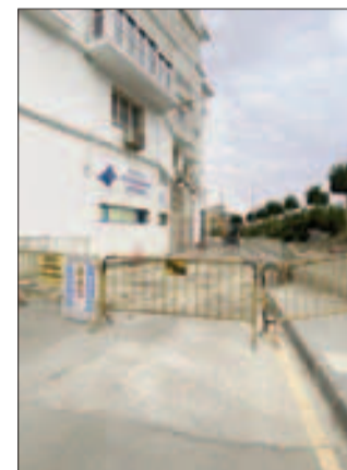
Inicio de obras en la travesía.
