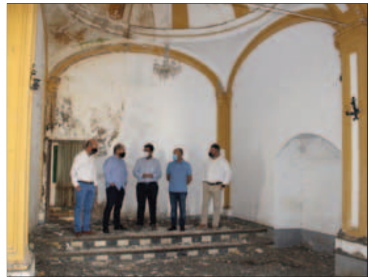
Visita efectuada al templo riofrío para comprobar su lamentable estado. C.M.
