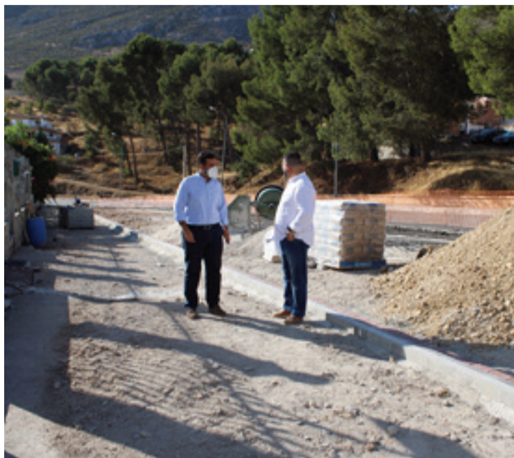
El alcalde de Loja y el concejal de Obras visitan el acerado en la 'Redonda'. C.MOLINA
