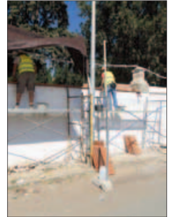
Trabajadores durante la actuación.
