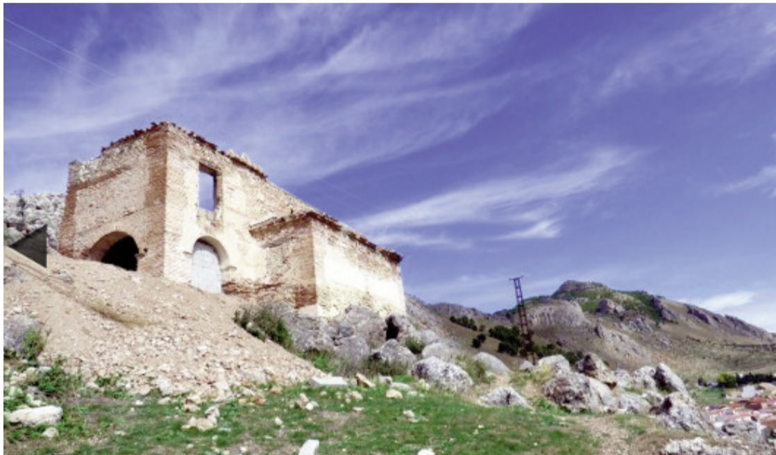
La ermita del Calvario, localizada en el Monte Hacho. FOTO: A. MATAS
