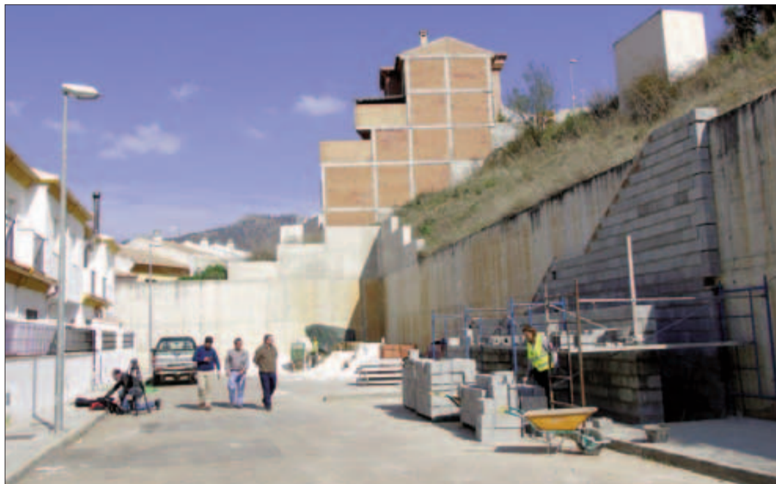
Escalera que se alza en el muro de contención de la avenida del Terciado en el barrio de San Antonio. FOTO: CALMA
