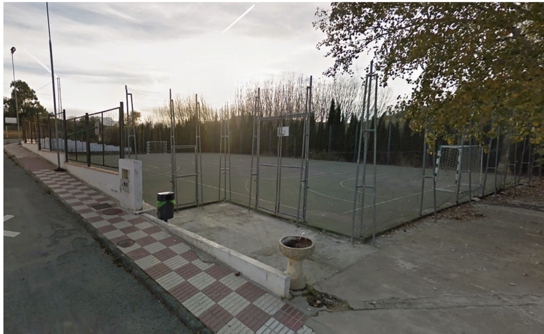
Estado actual que presenta la pista polideportiva de Riofrío, en la que se va a actuar en breve. FOTO: CORTO
