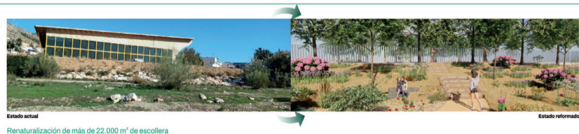
Renaturalización de más de 22.000 m 2 de escollera
